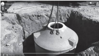
Einbau einer Betonzisterne:
