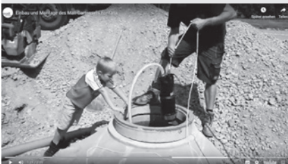
Einbau und Montage des Mall-Gartensets Fontana
