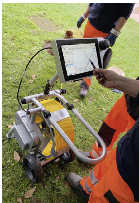
Mit der mobilen Schiebekamera-Anlage MiniLite kann eine 3D-Verlaufsmessung der Leitungen während der Inspektion durchgeführt werden. | Foto: IBAK
