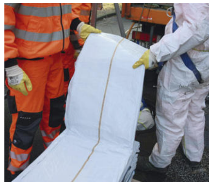
Berolina-Liner vor und nach der Installation | Fotos: BKP
