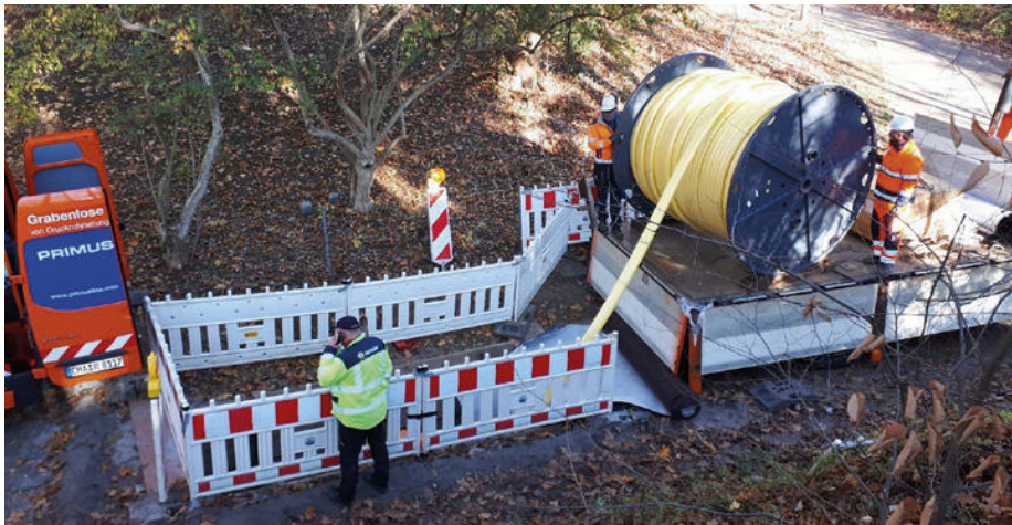
Der geringe Maschineneinsatz macht Primus Line zu einer CO 2 -sparende Lösung für die Druckrohrsanie rung. | Foto: Rädlinger primus line
