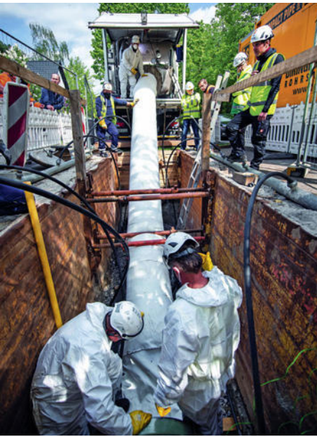
Das BlueLine-Verfahren ist für die grabenlose Sanierung von Druckrohrleitungen im Trinkwasserbereich entwickelt worden. | Foto: D&S-Unternehmensgruppe
