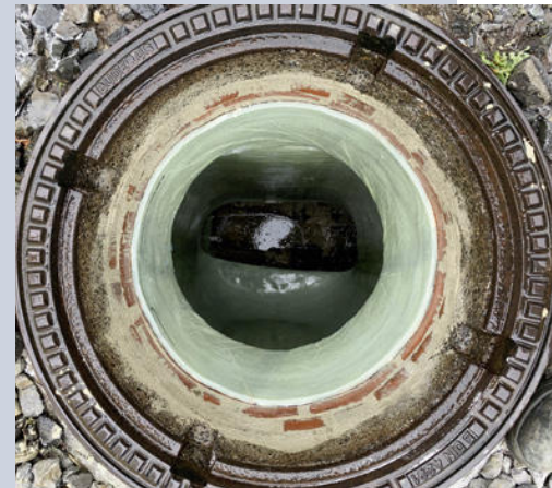
Der Schachtliner BBS.8 passt sich an die Schachtgeometrie an, weshalb keine aufwendigen Aufmaßarbeiten erforderlich sind. | Foto: Brandenburger Liner
