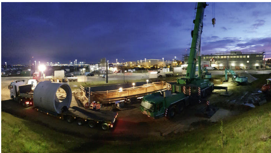
Arbeiten an der medialen Infrastruktur für den Flughafen BER | Foto: Beton & Rohrbau
